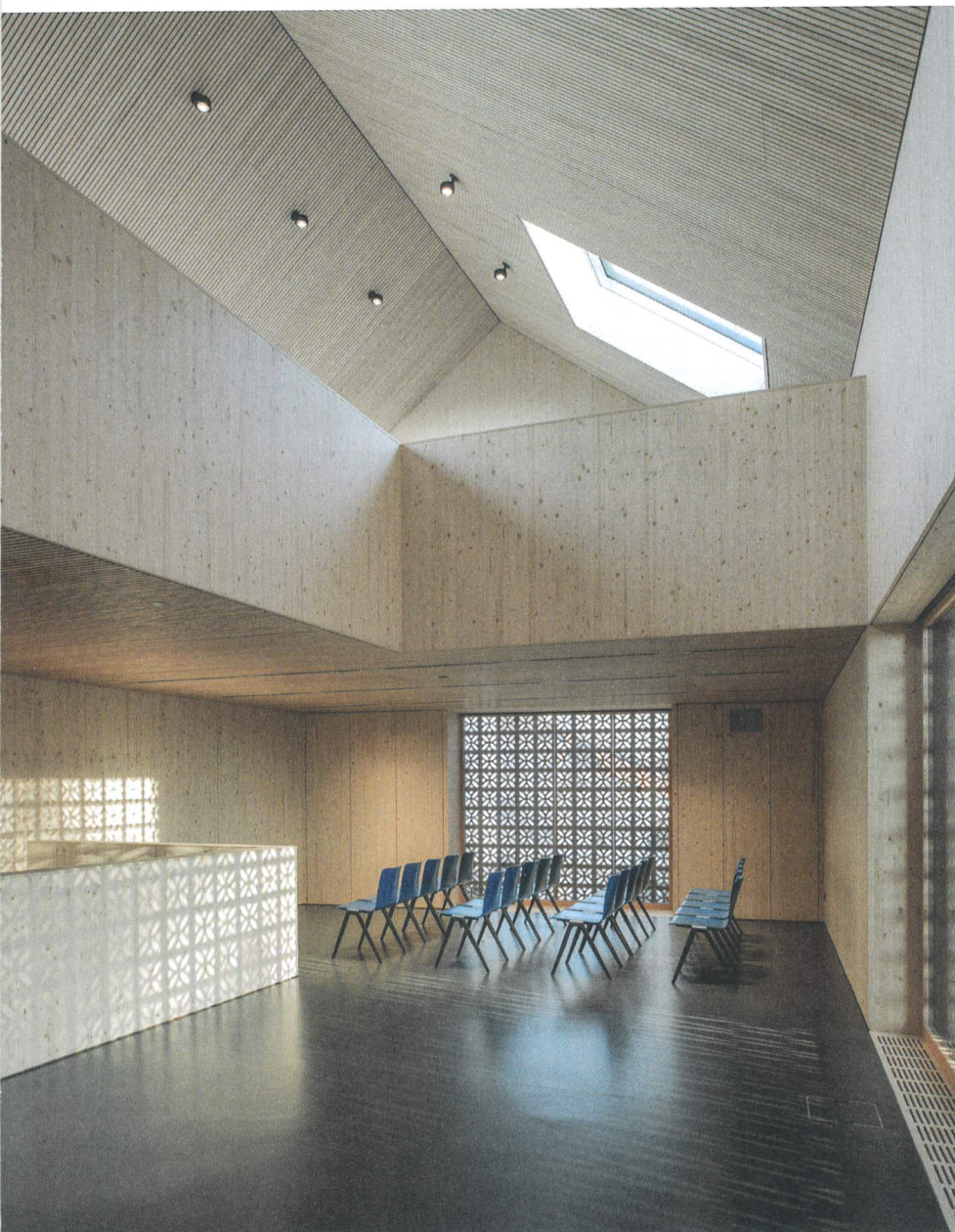
Im Seminarraum im Obergeschoss fällt das Licht durch die Fenster hinter der Ornamentfassade. Zum Reinigen kann die äussere Verkleidung weggeklappt werden.
