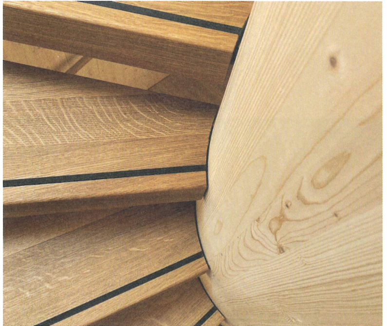
Die Fluchttreppe aus massivem Holz: Jeder Tritt, jede Montagebohrung und die Tragsäule wurden millimetergenau vorgefertigt.
